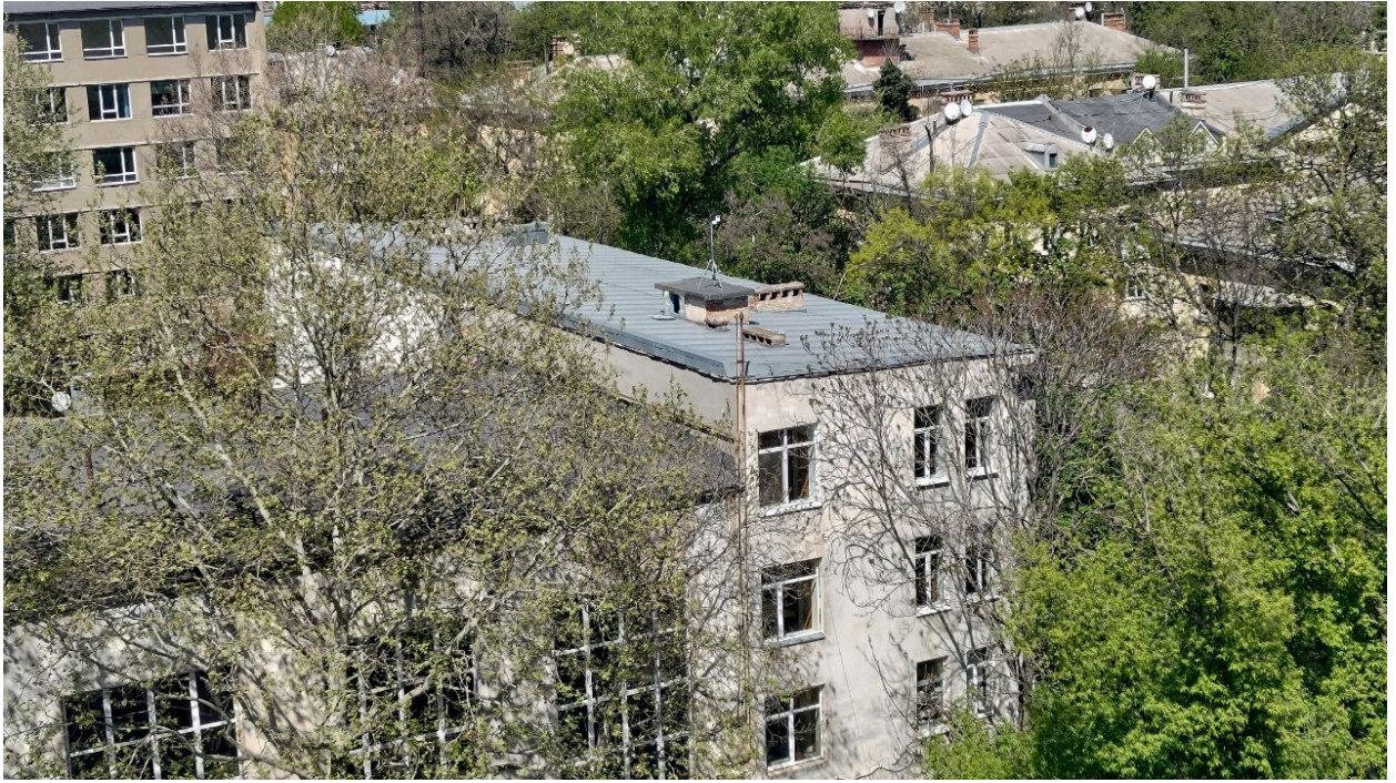
Рисунок 4.16 – Фото даху опалювальної котельні.
