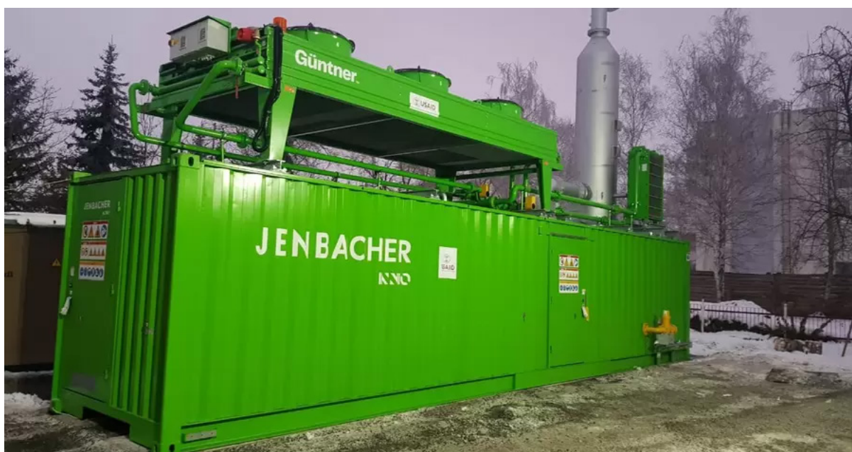
Рисунок. 1.1 – Зовнішній вигляд когенераційної установки фірми «Jenbacher», Австрія
