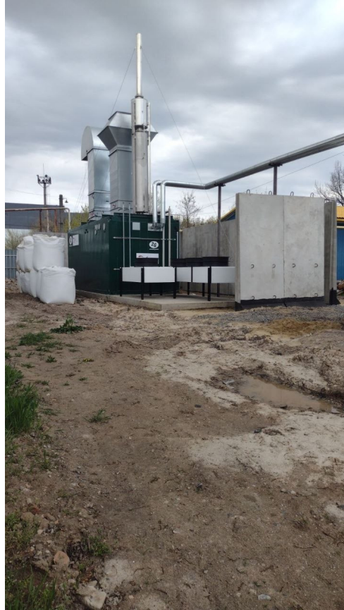
Рисунок 4.6 – Зовнішній вигляд встановленої когенераційної установки 2G G6738 (0,400 МВт, просп. Небесної сотні, 4)
