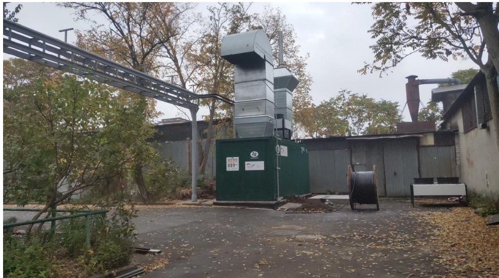
Рисунок 4.7 – Зовнішній вигляд встановленої когенераційної установки 2G G6739 (0,600 МВт, вул. Варненська, 23-а)
